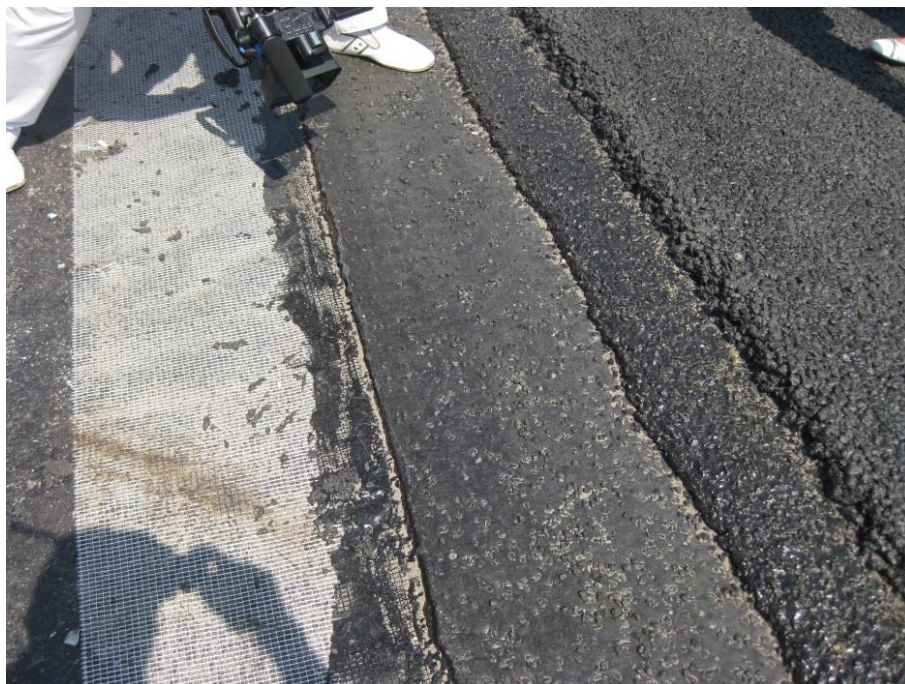
Рис. 17. уложенные слои дорожной одежды
