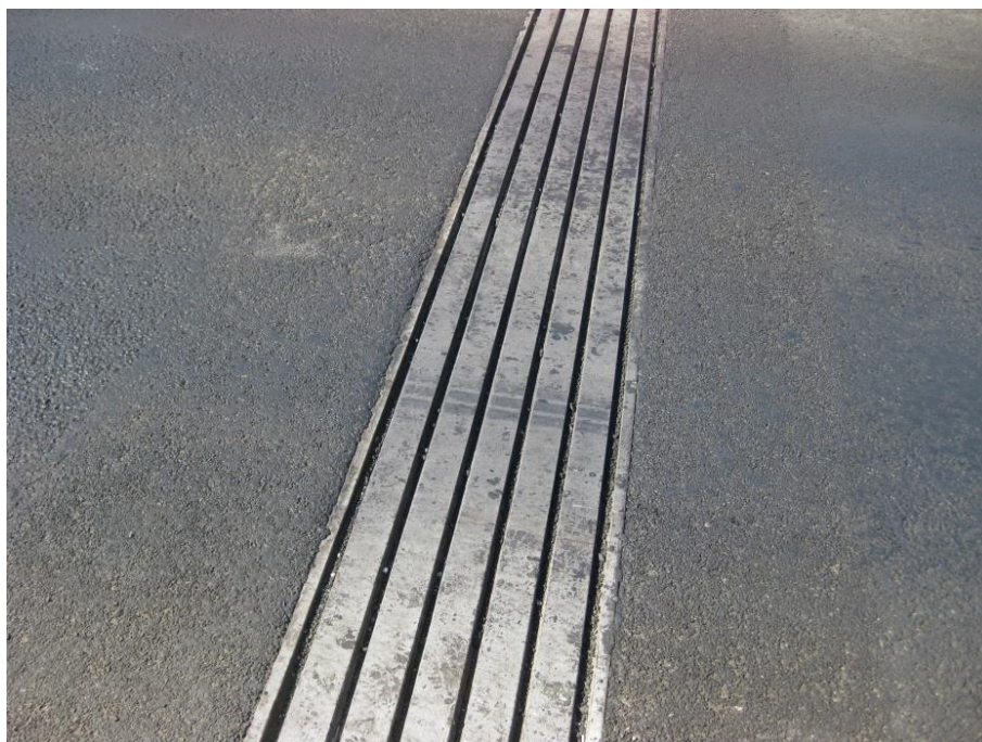
Рис. 18. устройство сопряжения дорожной одежды с деформационным швом
