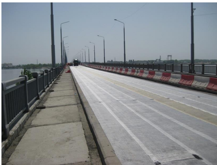
Рис. 14. сетка распределения давления (пароотводящая сетка)
