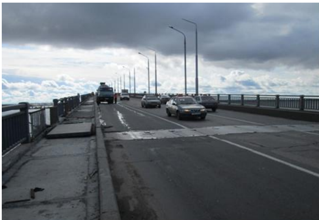
Рис. 2. Вид на мостовое полотнурусловой части моста со стороны опоры 6, деформационный шов над опорой 6 (до ремонта проезжей части)
