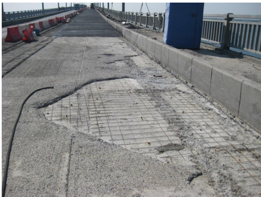
Рис. 12. Подготовка к укладке монолитного слоя бетона
