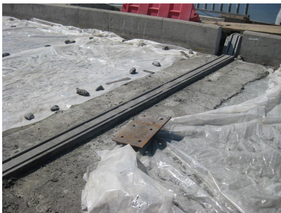
Рис. 13. уход за свежесуложенным на неровную поверхность плиты проезжей части выравнивающим слоем бетона
