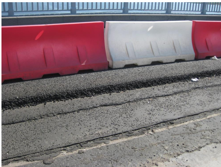
Рис. 16. уложенные слои дорожной одежды
