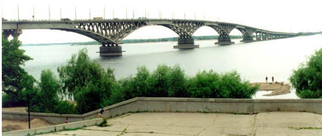
Рис. 1. Общий вид русловой части моста с низовой стороны. Вид с набережной г. Саратова
