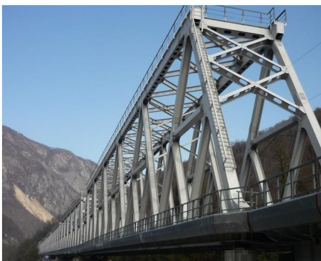
Рис. 2. Вид металлоконструкций железнодорожного моста на ПК 219
