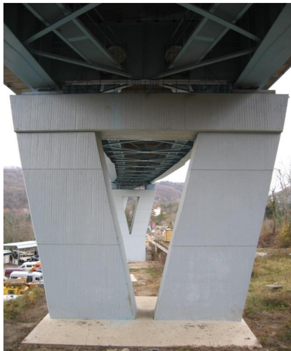
Рис. 6. Опоры моста через реку Мацесту
