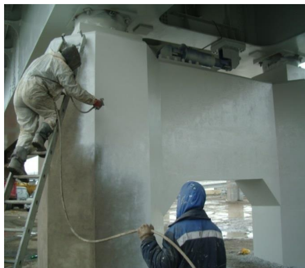
Рис. 5. Окраска железобетонных конструкций на ПК 0+00
