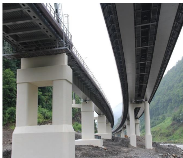
Рис. 3. Вид автодорожного моста на ПК 352
