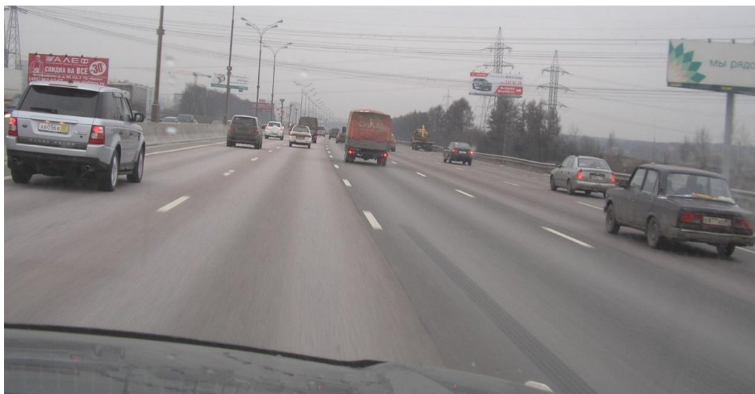
Рисунок 1. Участки дорожного покрытия из сероасфальтобетона на МКАД (фото авторов)
