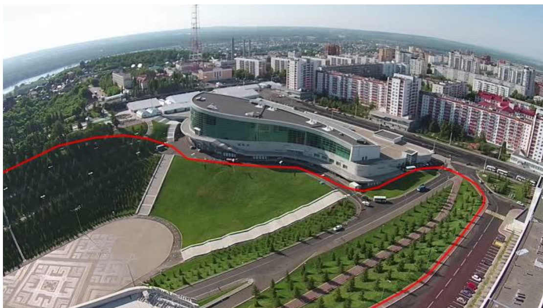
Рисунок 5. Склон за зданием Конгресс-холла после проведения ландшафтных работ (составлено авторами)
