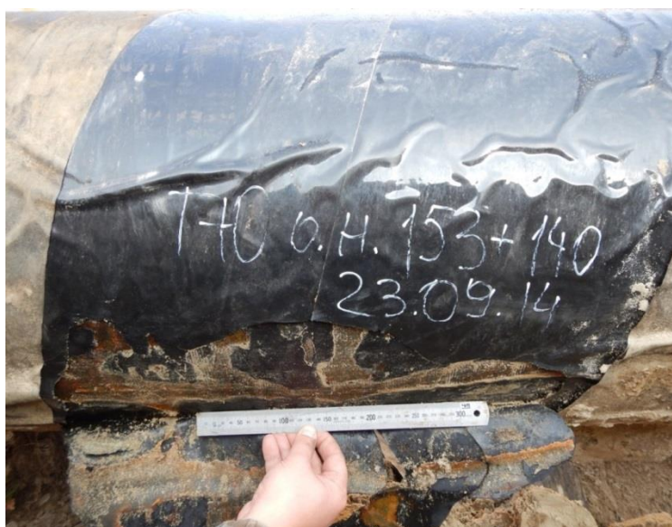
Рисунок 5. Контрольный шурф на нефтепроводе Т-Ю, выполненный по результатам диагностического обследования
