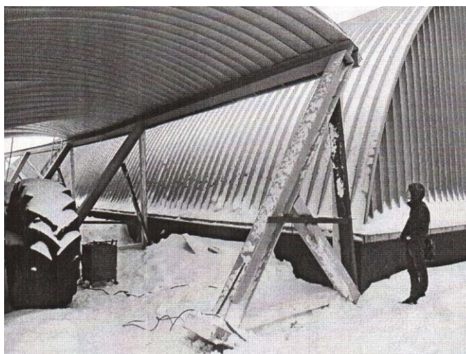
Рисунок 7. Потеря устойчивости основных несущих конструкций каркаса (разработано автором)
