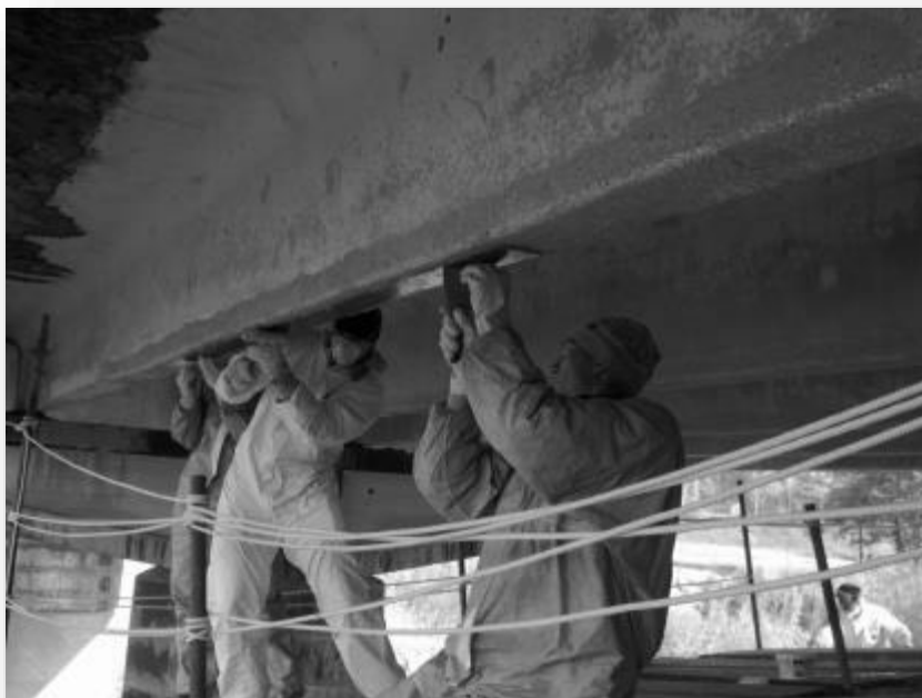
Рис. 11. Усиление пролетного строения моста через реку Карпысак
