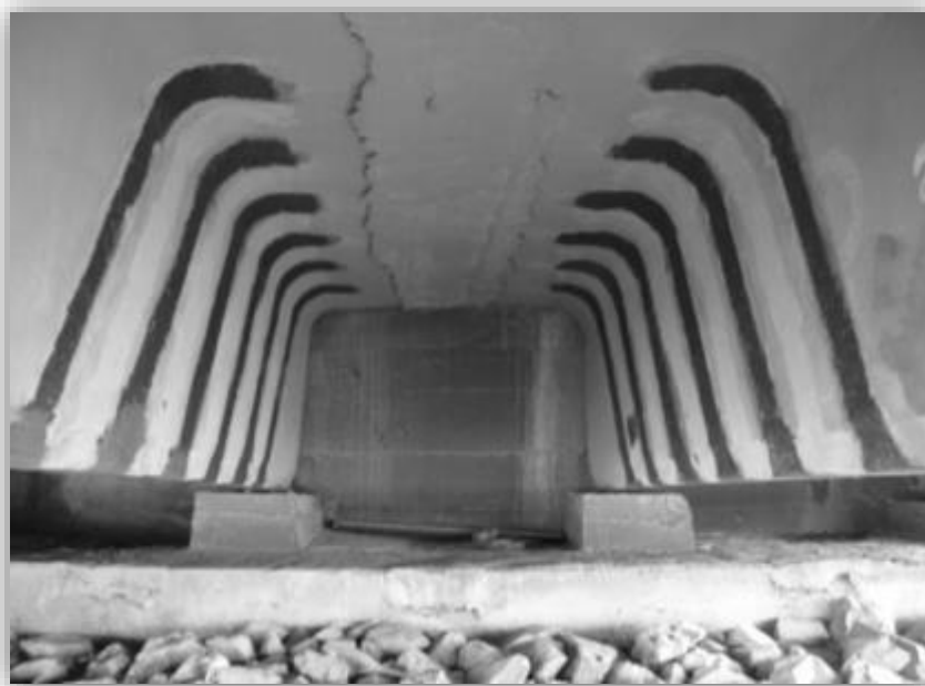
Рис. 12. Вид усиленного ПС №1 моста через реку Тарсьма
