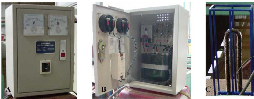
**Рисунок 5.** Шкаф управления генератора, балластная нагрузка (составлено автором)
