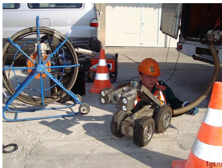
Рисунок 2. Фрагмент работы оператора по подготовке робота к проверке засоренности труб (источник: 1gs.ru )
