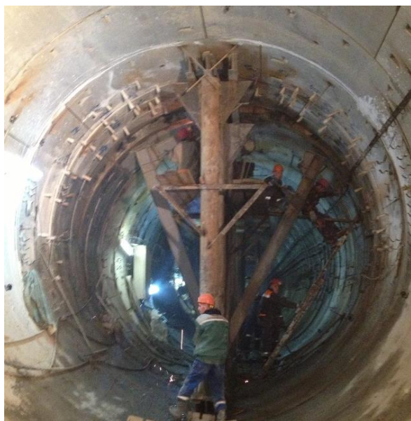
Рисунок 10. Изменение поперечного сечения тоннеля в результате просадки грунта
