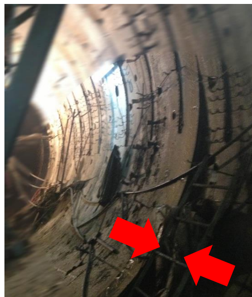
Рисунок 10. Изменение поперечного сечения тоннеля в результате просадки грунта
