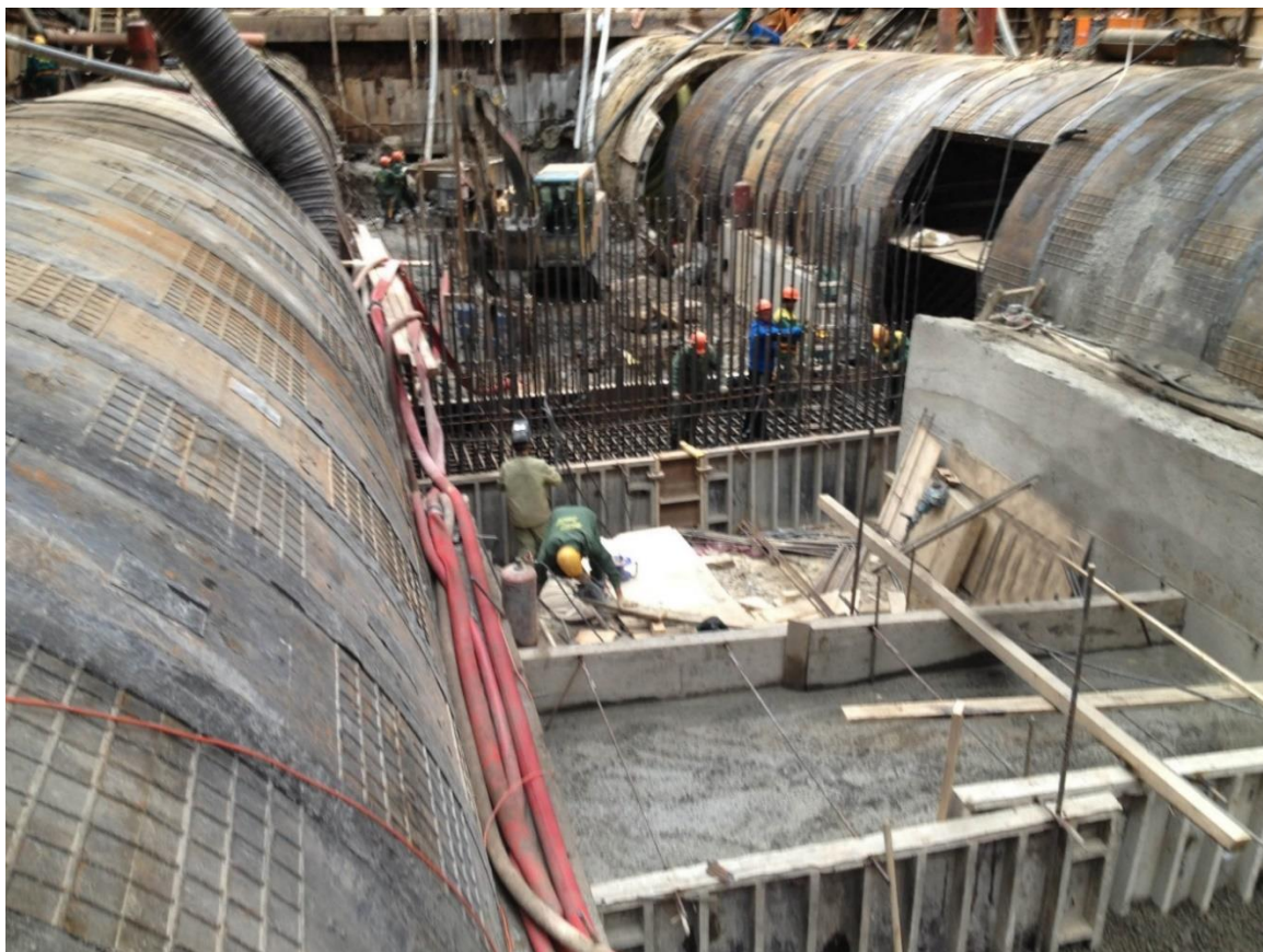
Рисунок 9. Устройство железобетонных перемычек, технологической сбойки и бетонной «рубашки»
