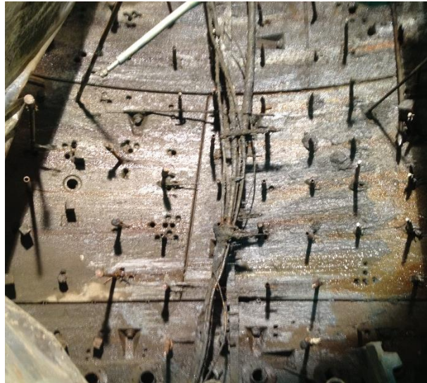
Рисунок 15. Химическое закрепление грунта трехкомпонентным раствором из тоннеля
