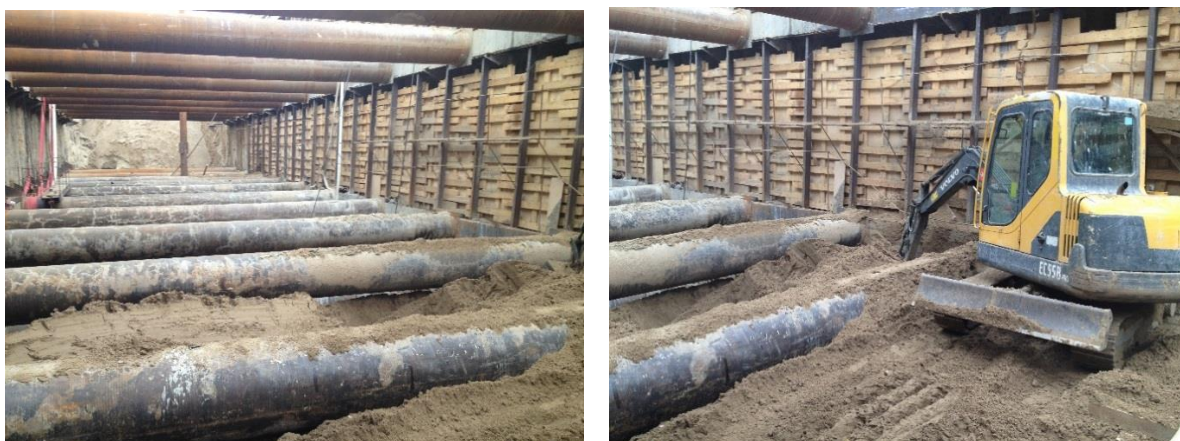
Рисунок 18. Обратная засыпка грунта в котлован
