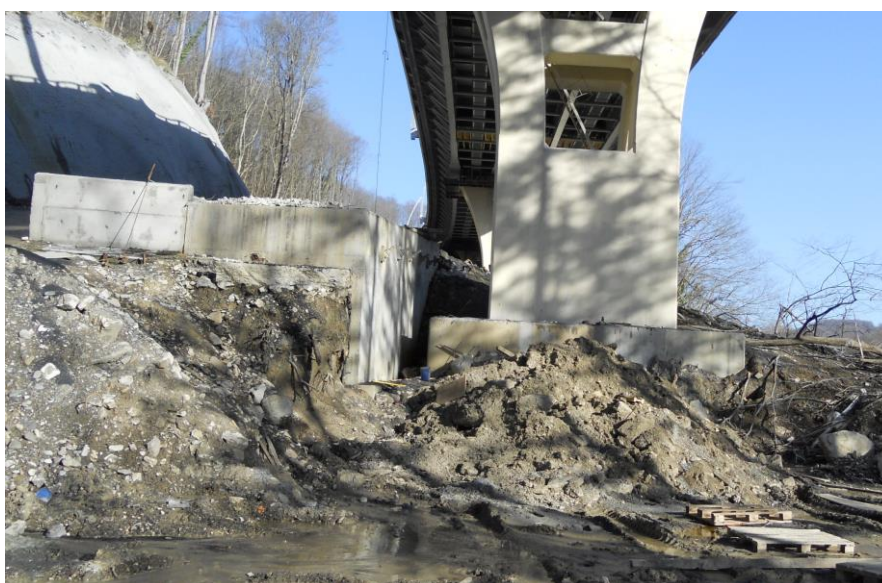
Рис. 8. Оползневой склон с опорами эстакады и противооползевыми сооружениями (разработано автором)
