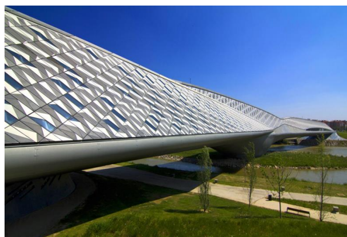
Рисунок 5. Покрытие моста – павильона из треугольных панелей (источник: http://loveopium.ru/arxitektura/idealnyj-sovremennyj-universitet.html )
