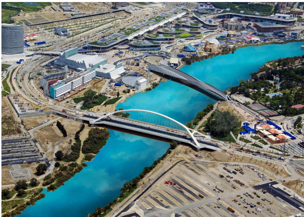
Рисунок 6. Вид на мосты в Сарагосе. Дальний – мост павильон (источник: Вода и устойчивое развитие. Отчет об участии Российской Федерации во Всемирной выставке. ЭКСПО-2008)
