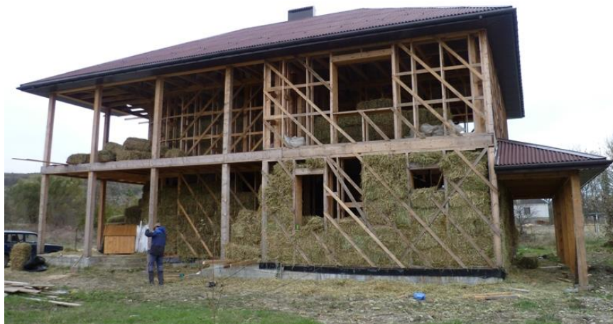
Рисунок 2. Строительство дома из соломенных блоков классическим способом 2
