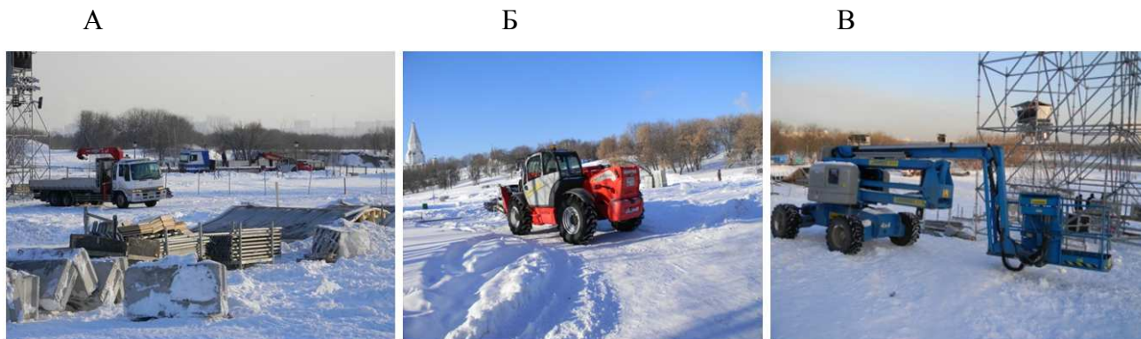
Рис. 4. Временная строительная база. А-склад материалов, Б, В - техника в работе (фото автора)
