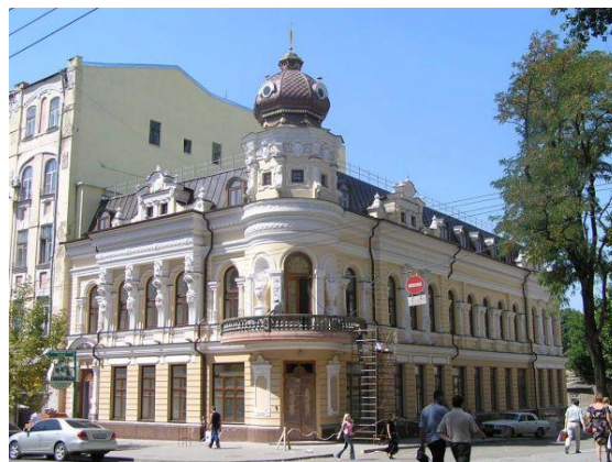
Рисунок 2. Дом Маргариты Черновой – здание в Ростове-на-Дону, расположенное на Большой Садовой улице (дом 27/47) (составлено автором)
