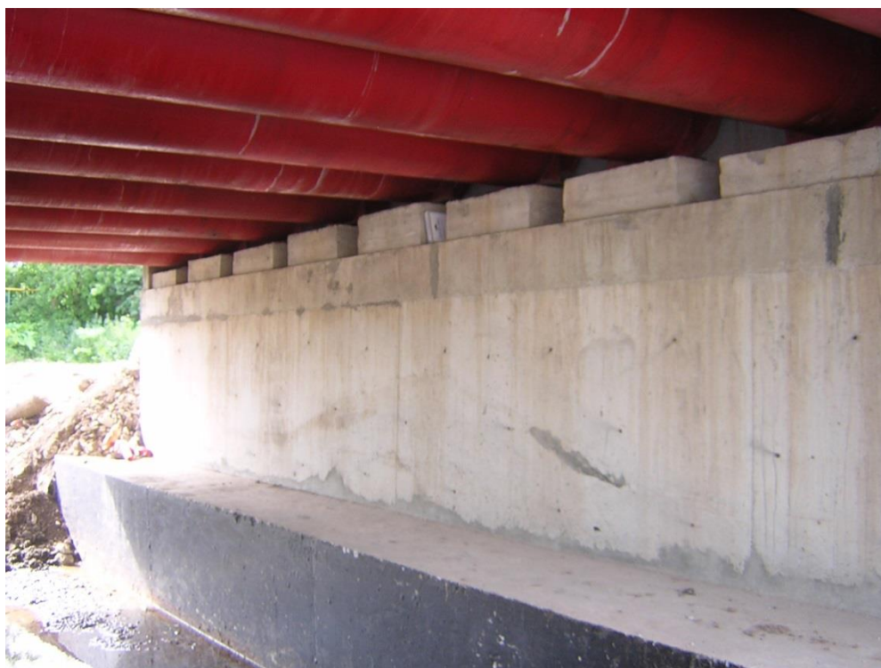
Рис. 7. Мост с использованием труб на автодороге Казань-Киров км 125+771; а) общий вид моста, б) трубчатое пролетное строение
