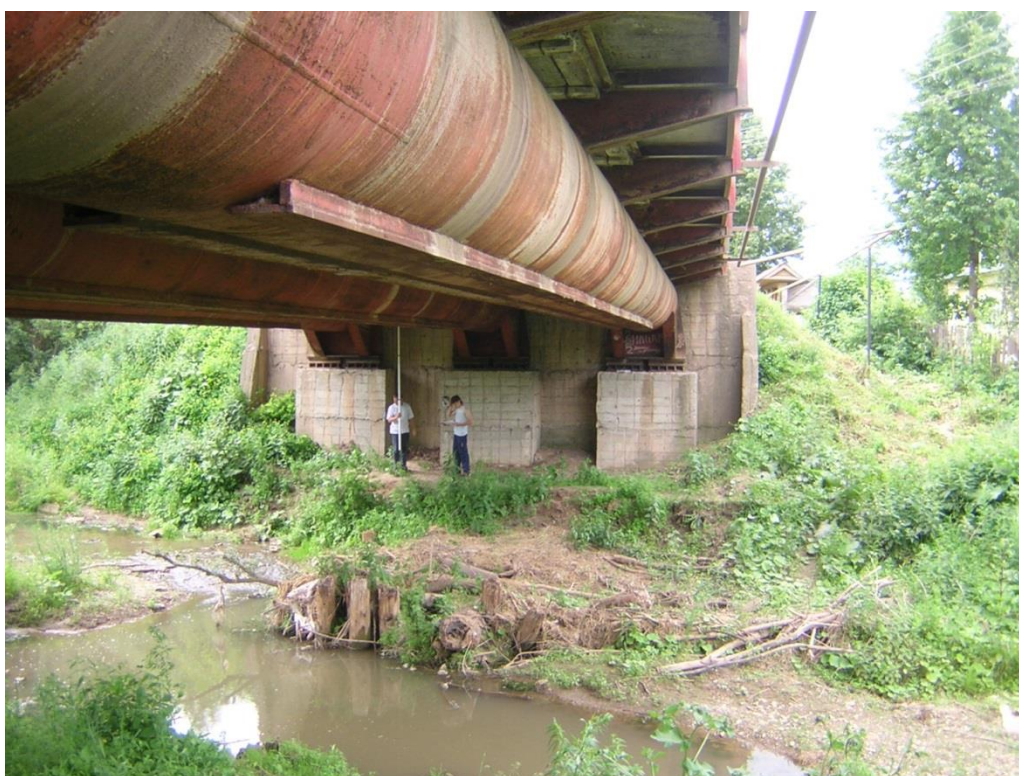
Рис. 10. Мост с использованием труб на автодороге Казань-Киров км 116+440; а) общий вид моста, б) конструкция пролетного строения и зоны опирания
