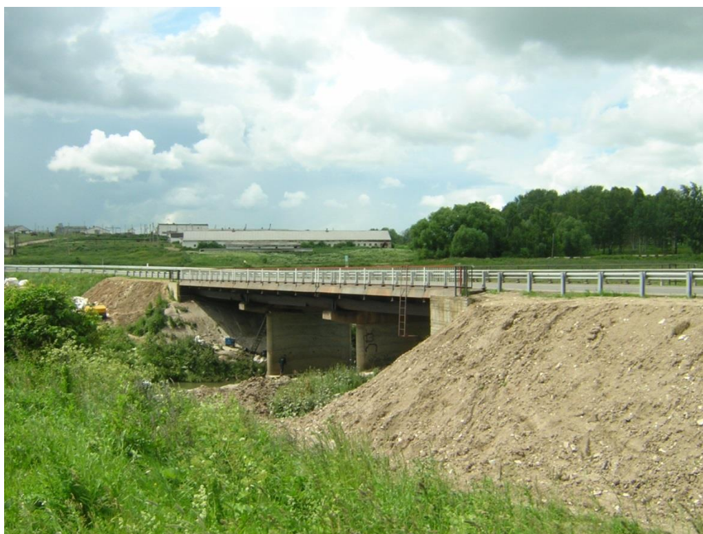
Рис. 4. Трехпролетный трубчатый мост на автодороге Казань-Киров км 72+116
