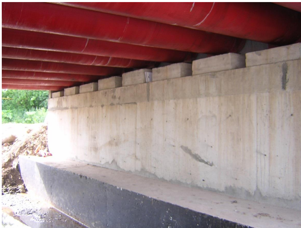
Рис. 1. Трубчатый мост на автодороге Казань-Киров км 125+771
