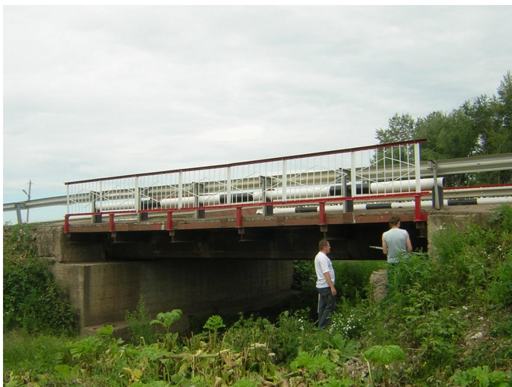
Рис. 2. Однопролетный трубчатый мост на автодороге Казань-Киров км 123+684
