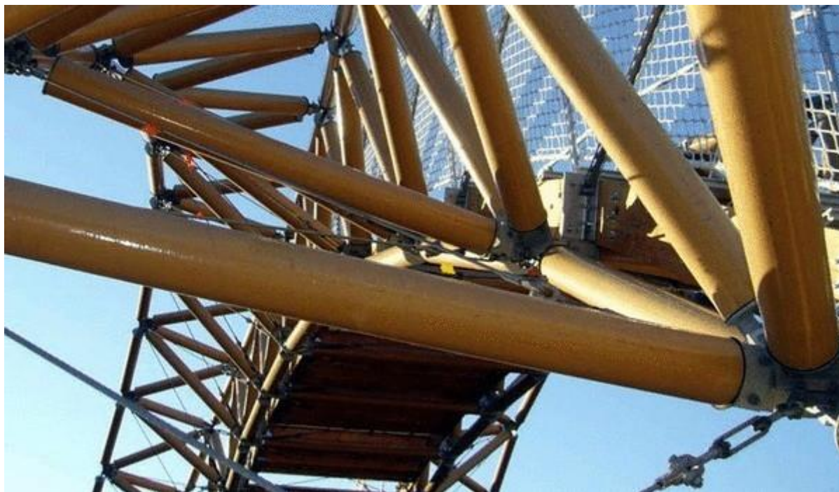
Рис. 4. Вид на несущую арочную ферму и узловые элементы моста. Источник: http://been-seen.com/travel-blog/art-and-design/paper-bridge
