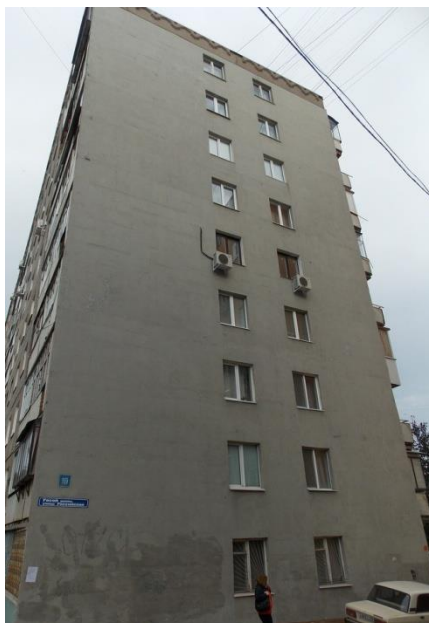
Рис. 3. Улица Российская дом 169, г.Уфа, (ремонт в 2000 г)
