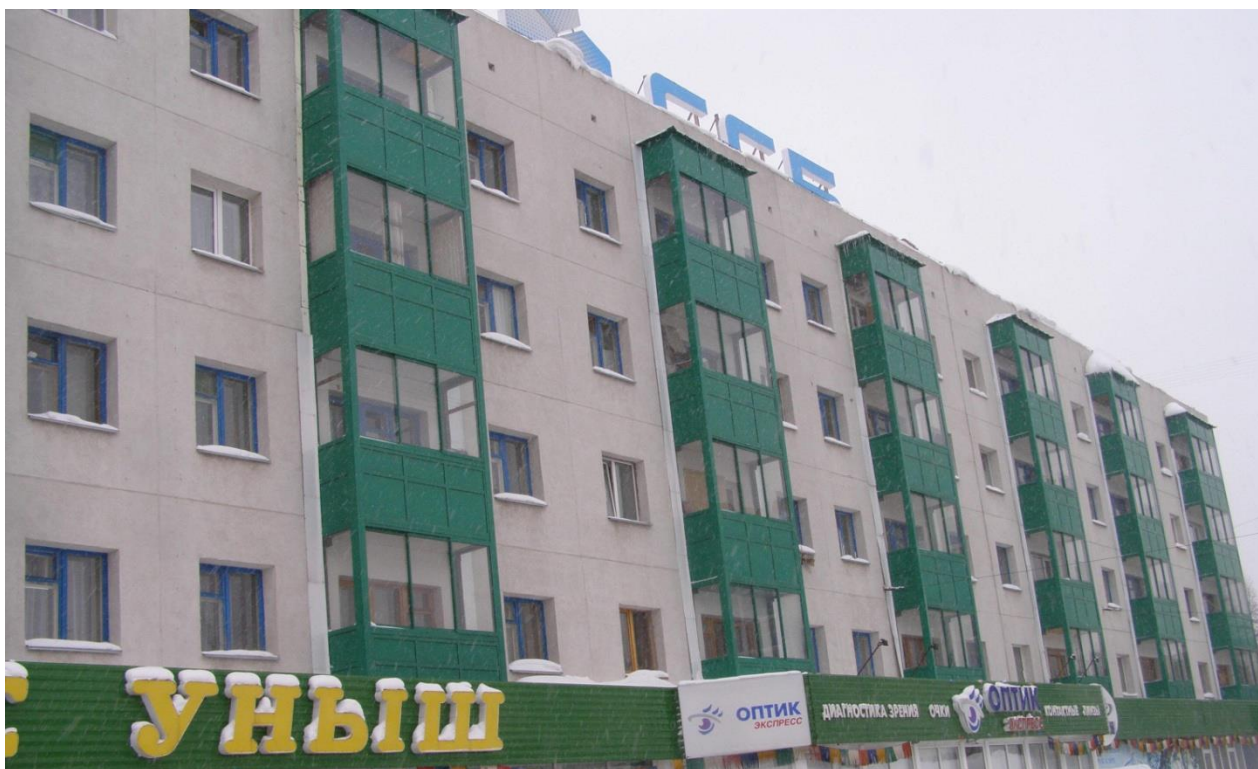
Рис.1. Улица 50 лет Октября, 3, г. Уфа (ремонт в 1996 г)
