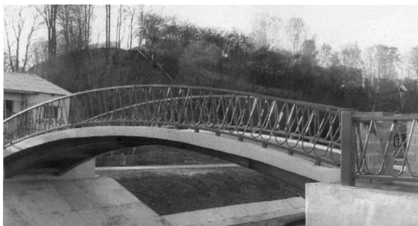
Рис. 2. Пешеходный мост через реку Дубровенка в г. Могилеве (2005 г.)
