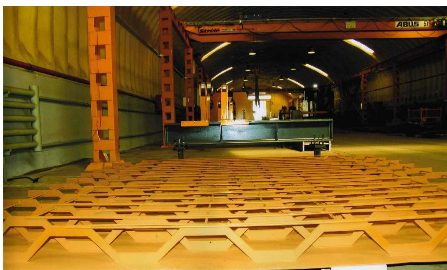
Рис. 5. Опытный образец КНЭСК (март 2012 г.) для второй очереди путепровода по ул. Полесской в Гомеле
