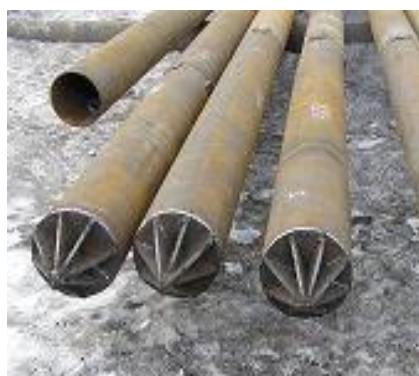
Рисунок 2. Предложенный подрядчиком вариант усиления оголовка сваи (составлено автором)
