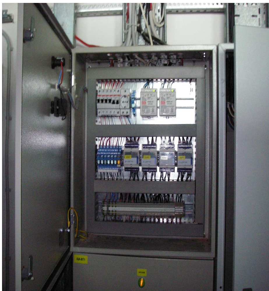
Рис. 8. Исправленное электроподключение элементов автоматики в шкафах управления
