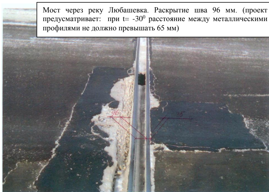
Рис. 2. Значительное раскрытие шва при отрицательных температурах
