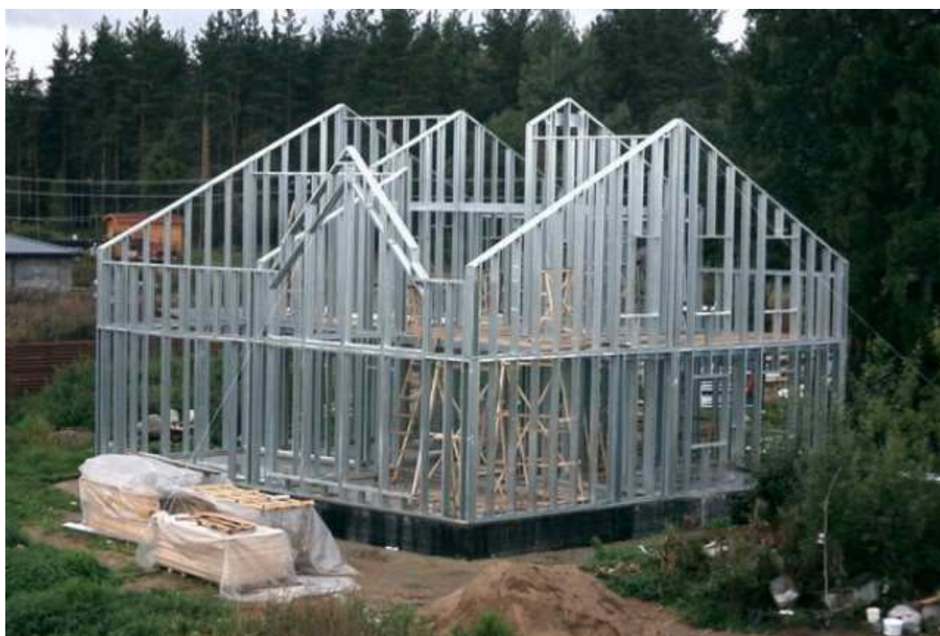
Рис. 2. Легкокаркасное здание из ЛСТК
