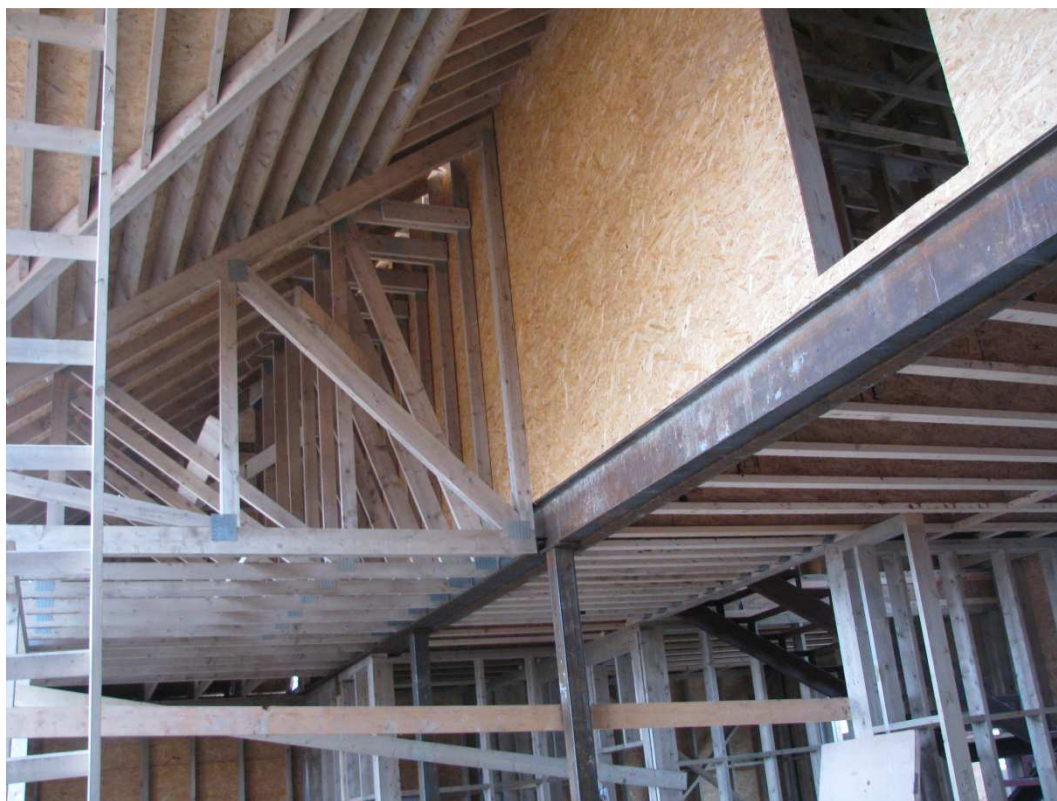
Рис. 3. Дом со смешанным каркасом
